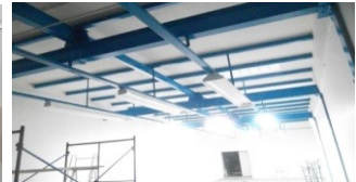
colocación de iluminación
